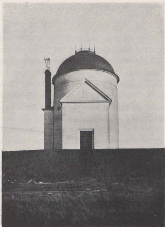
Hälsingborgs Eldbegängelsetempel, sett från väster.
