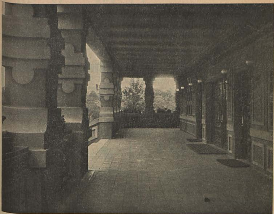
Arkádový ochoz a hlavní vchod do obřadní síně, po stranách nyky pro úschovu uřen.
