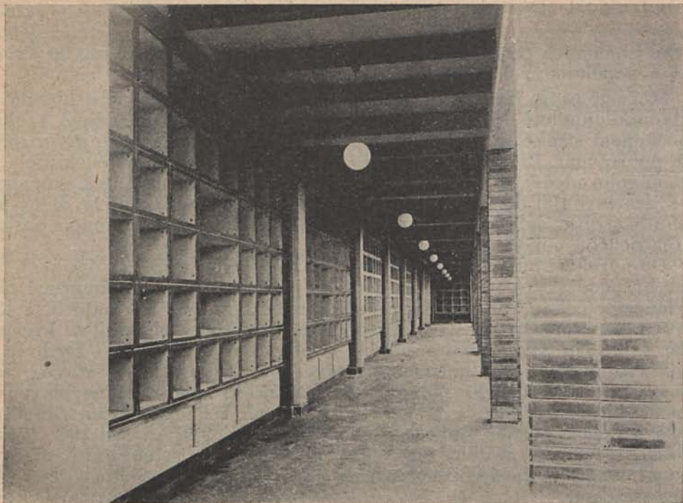
Levá část nového kolumbaria v Pardubicích.
