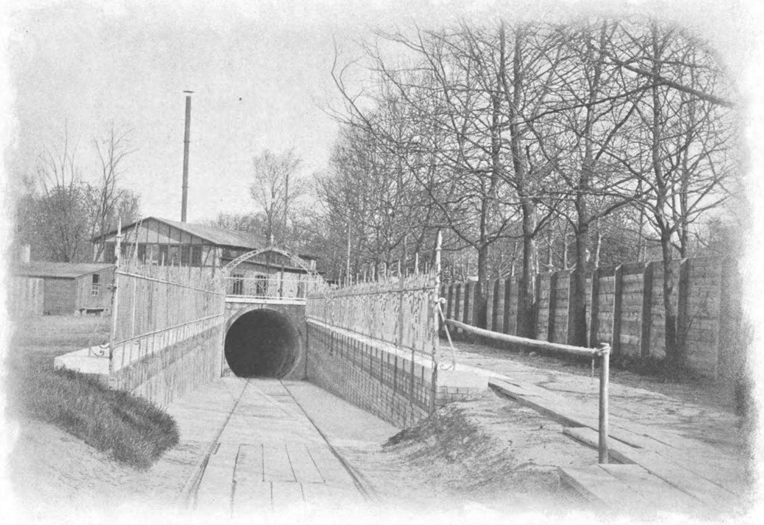
BERLIN. Untergrundbahn; Tunneleingang bei Treptow Chemin de fer souterrain; Entrée du tunnel près Treptow Underground Electric Tramway; Entrance of Tunnel near Treptow.
