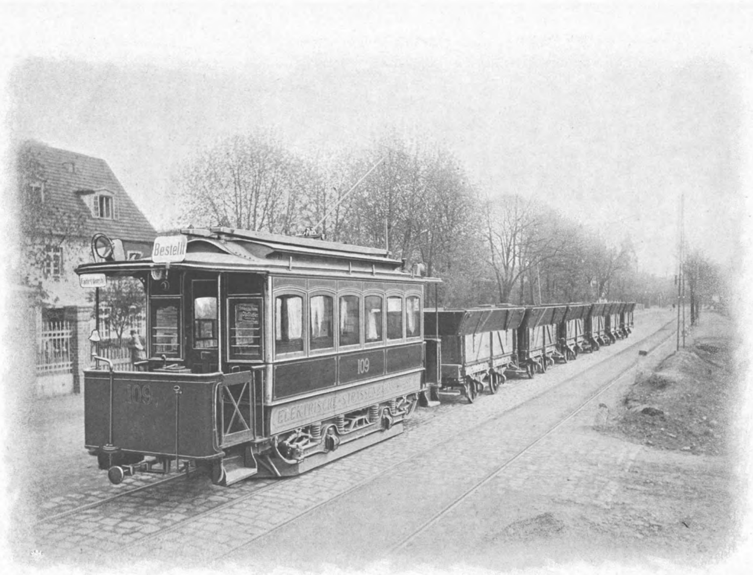
BRESLAU, Motorwagen als Lokomotive zu Erdbeförderungs-Arbeiten
