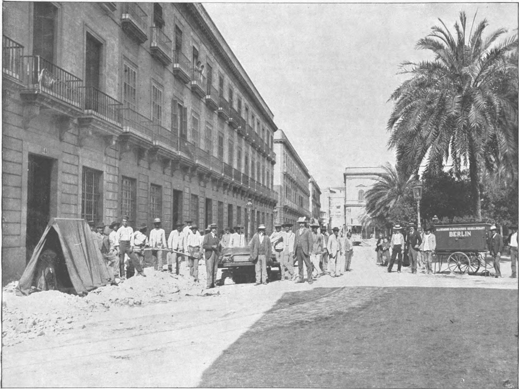
SEVILLA, Plaza San Fernando. Kabelverlegung — Pose des câbles — Laying mains.
