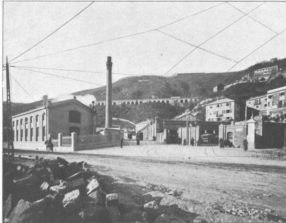
GENOVA, Depot und Werkstätten — Dépôt et ateliers — Car houses and workshops.
