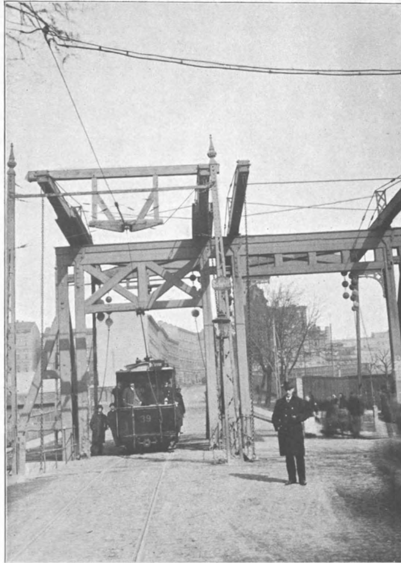
STETTIN, Bredower Klappbrücke.
