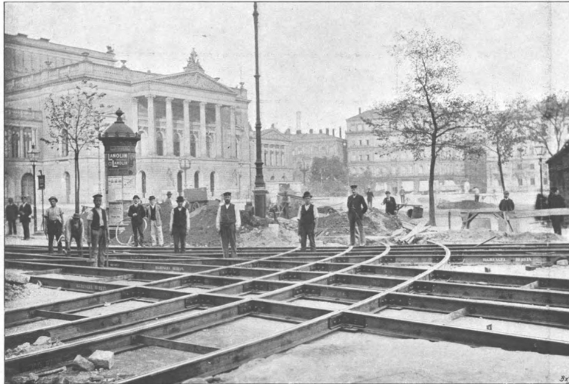
LEIPZIG, Gleis-Verlegung — Pose d'un croisement — Laying crossings.
