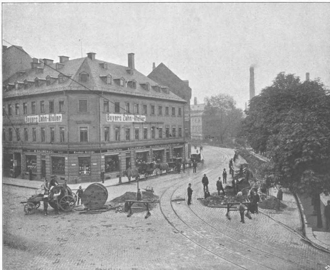
CHEMNITZ, Kabelverlegung — Pose des câbles — Laying of mains.
