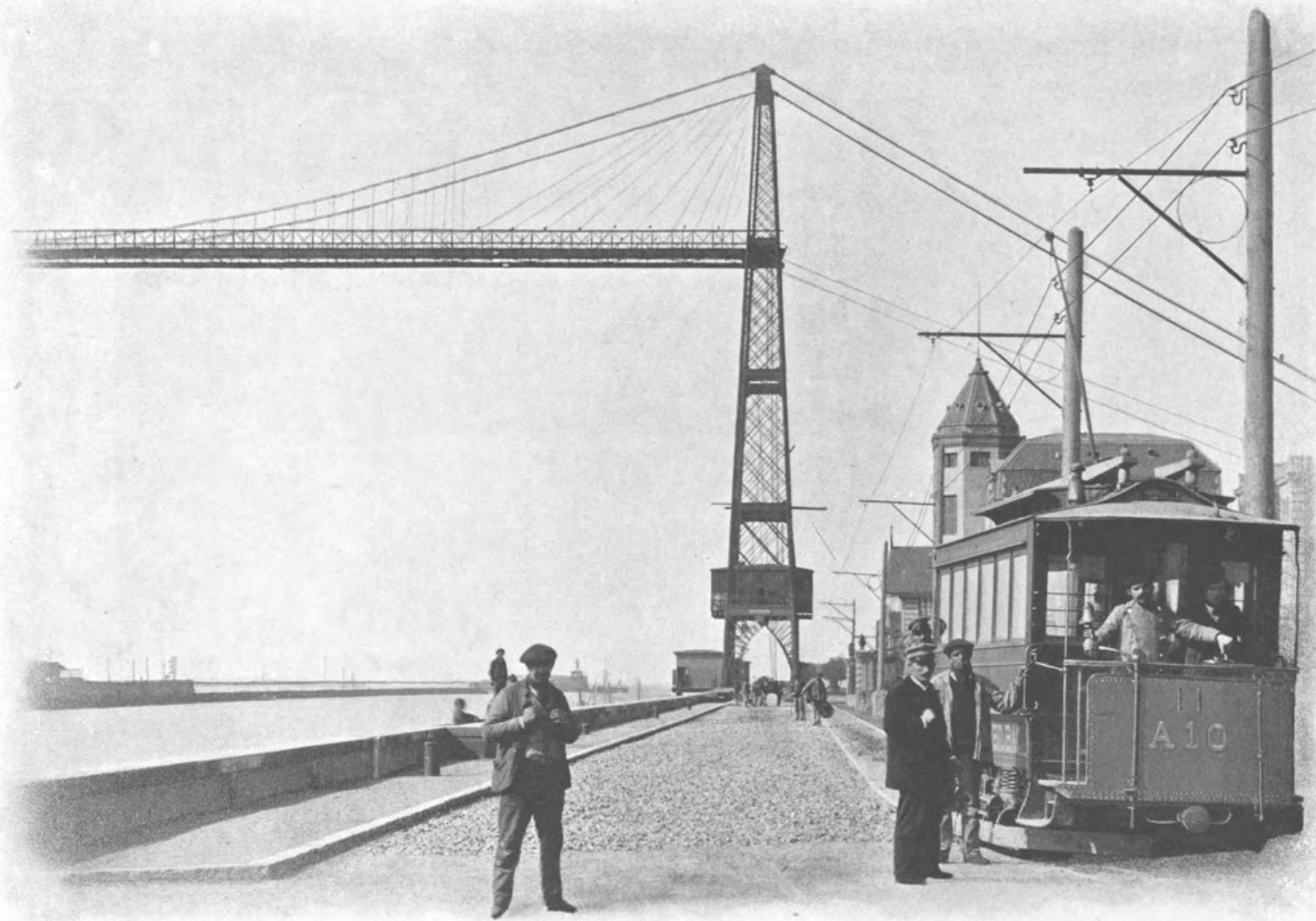
BILBAO - LAS ARENAS.
